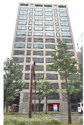
上：新宿三井ビルディング二号館 （日本ビルファンド投資法人）
