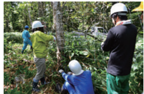
シカの食害から苗木を守るための柵の設置作業©日本野鳥の会
